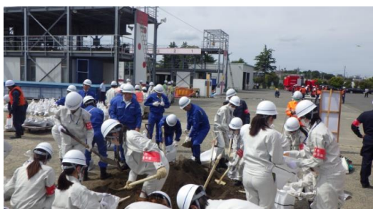
6-2 低地浸水防ぎょ訓練(土のう作成) 新採用職員
