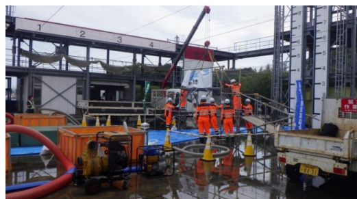
6-7 仮設人道橋設置訓練 一般社団法人藤沢市建設業協会
